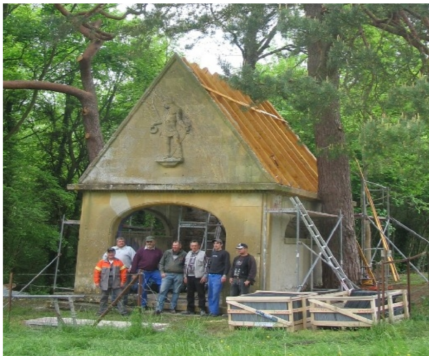
Einbau des neuen Dachstuhls durch das deutsche Team im Mai 2010
