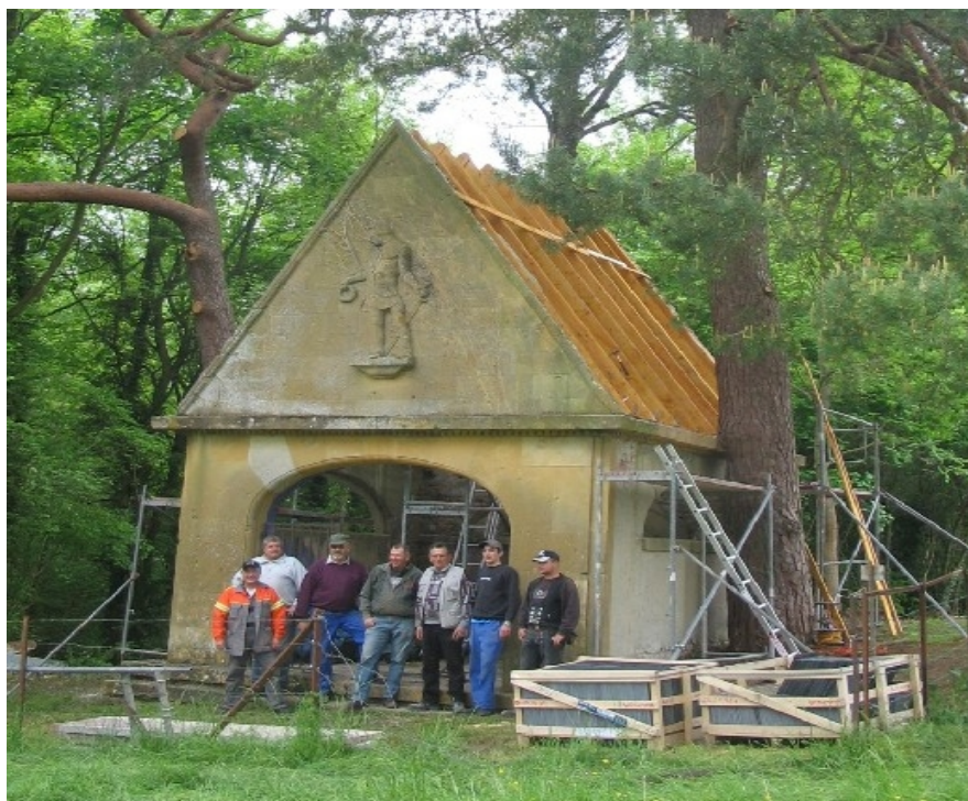
Pose de la nouvelle charpente par l'équipe allemande. Mai 2010
