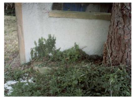
Überdies hat eine kräftige Efeuranke schon vor einigen Jahren einen ansehnlichen Stein, der sich über der rechten Seitenwand der Kapelle befand, herunterfallen lassen. Dieser Stein, der den Dachstuhl abgestützt hatte und nun fehlt, setzt ihn nunmehr umso mehr der Gewalt des Windes aus.
