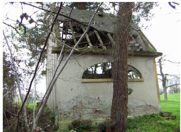
Im Übrigen dringt durch die großen Löcher im Dach Regenwasser ein, greift den Dachstuhl an, hat - weil es an den Wänden herunterläuft - die hölzerne Decke und den preußisch-blauen Putz zerstört und beginnt nun auch die Stützmauer aus Beton, welche die Fassade des Gebäudes abstützt, anzugreifen.
