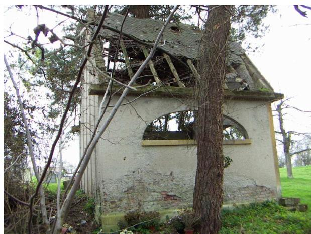
Par ailleurs, les trous béants dans la toiture laissent pénétrer à l'intérieur de la chapelle la pluie qui ronge la charpente, et qui ruisselant le long des murs à déjà eu raison, outre de la voûte en bois et du crépi couleur « Bleu de Prusse », commence aussi à désagréger le mur de béton qui soutient la façade du bâtiment.
